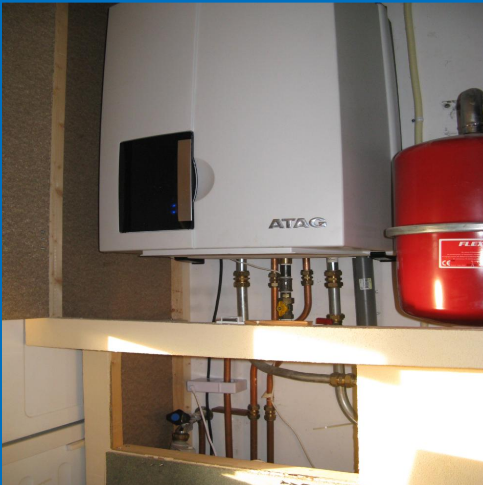
De HydroFLOW HS-38 gemonteerd onder een combiketel.
